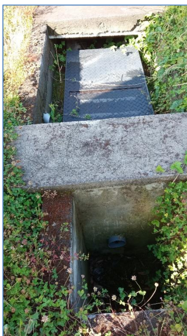
Figura 4.1: Separador de hidrocarbonetos.
