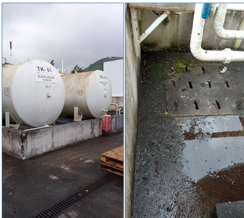
Figura 5.2: Armazenagem de óleos usados (bacia de retenção).
