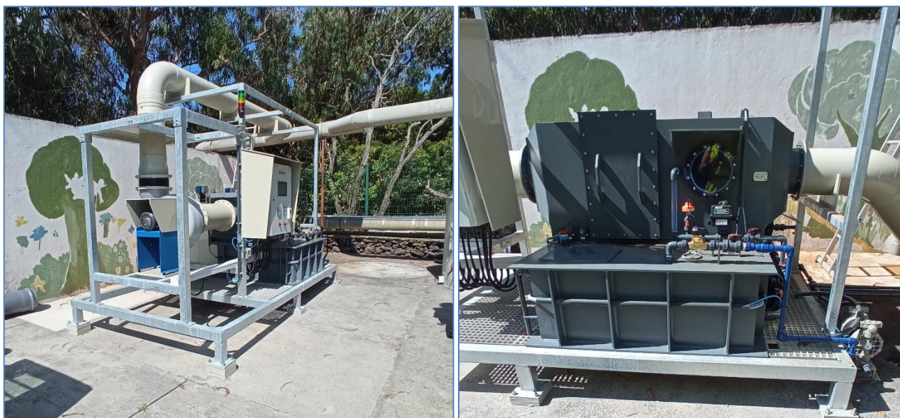
Figura 2.1: Lavador de gases horizontal.
