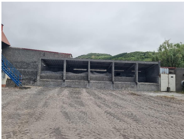
Figura 4: Baías de armazenamento, com cobertura, de matéria prima para fabricação do betão pronto.
