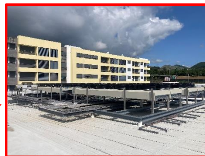
Figura 3 - 12 ventiladores antigos + 32 ventiladores novos, dos 4 gas-cooler's
