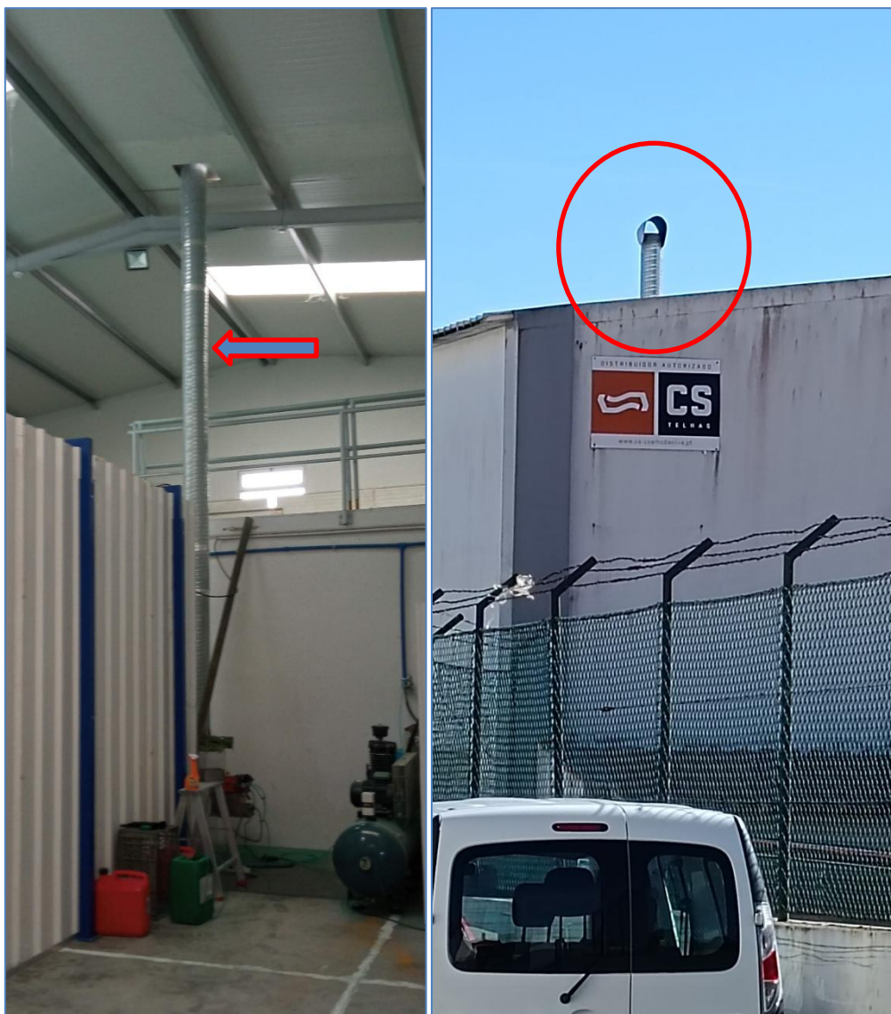
Figura 2.3: Chaminé do queimador de gasóleo (interior e exterior).
