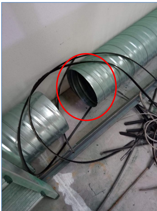
Figura 2.2: saída da conduta de aspiração do filtro de mangas.
