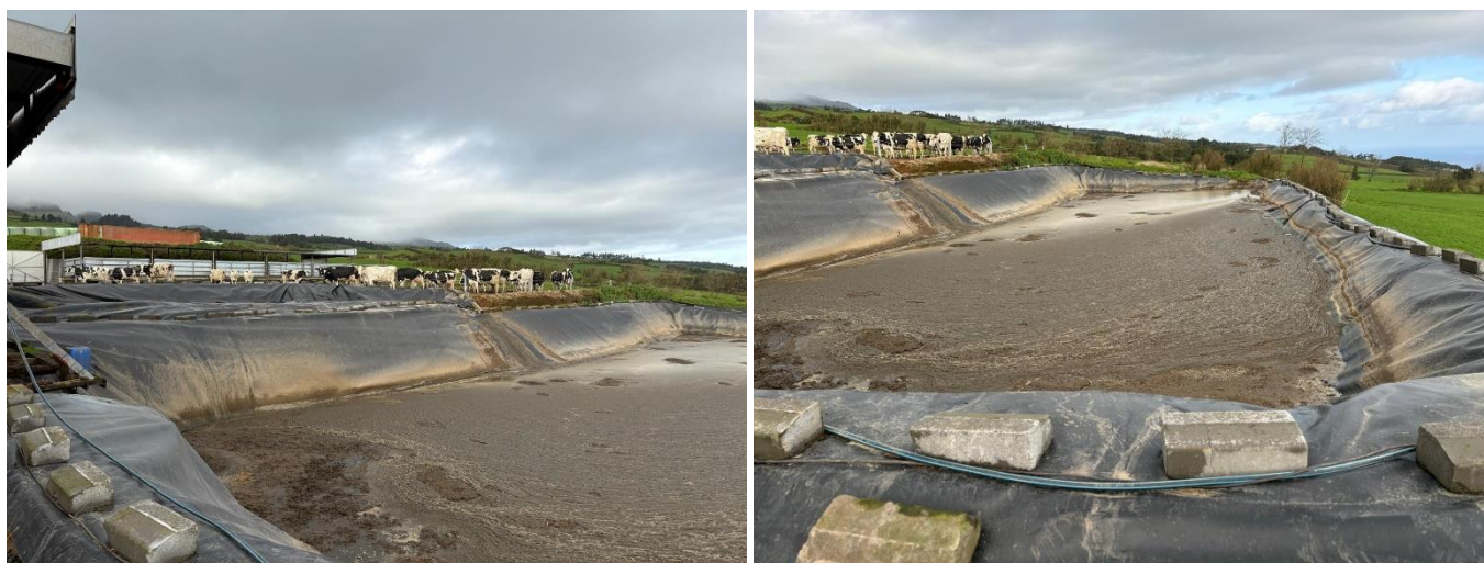
Figura 2 e 3 – Fossas impermeabilizadas com tela.
