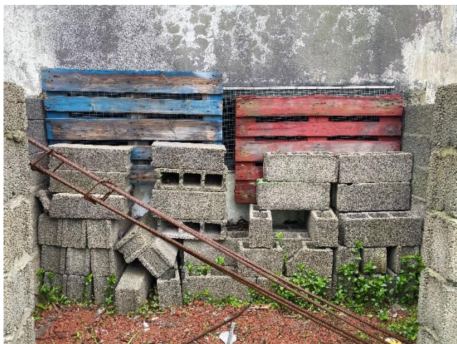
Foto 9 – Zona da exaustão da extração da cabine de pintura, sem chaminé.
