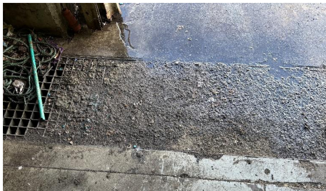
Foto 1 – Vala da entrada do pavilhão.
