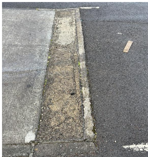
Foto 4 – Vala de proteção à balança.
