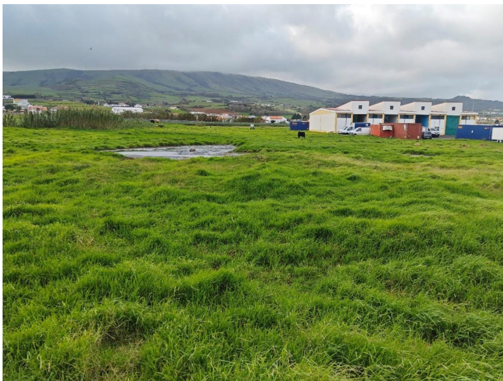
Foto 2 – Zona onde é perceptível a acumulação das águas pluviais descarregadas.
