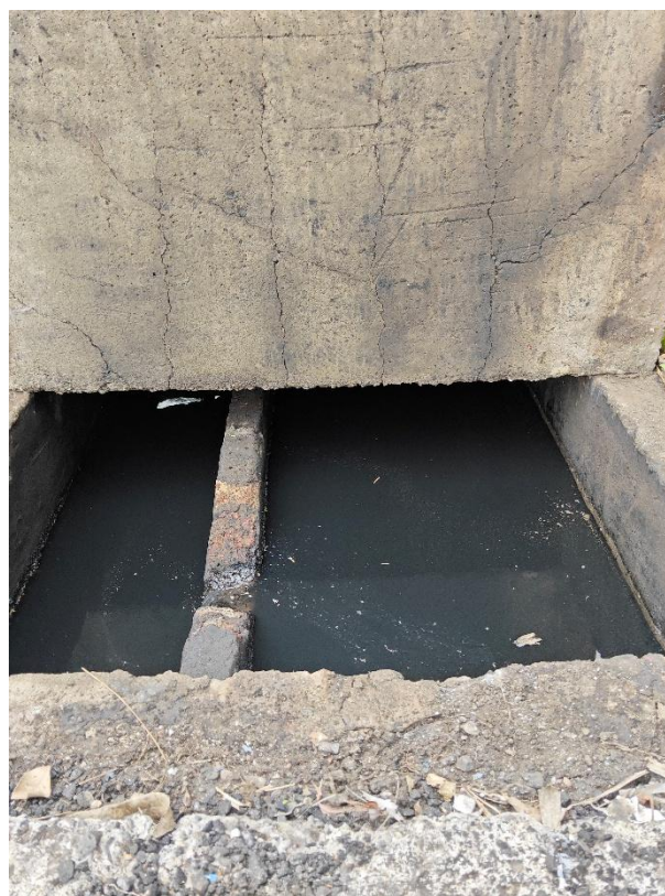
Foto 2 – Caixa de receção de águas da lavagem
